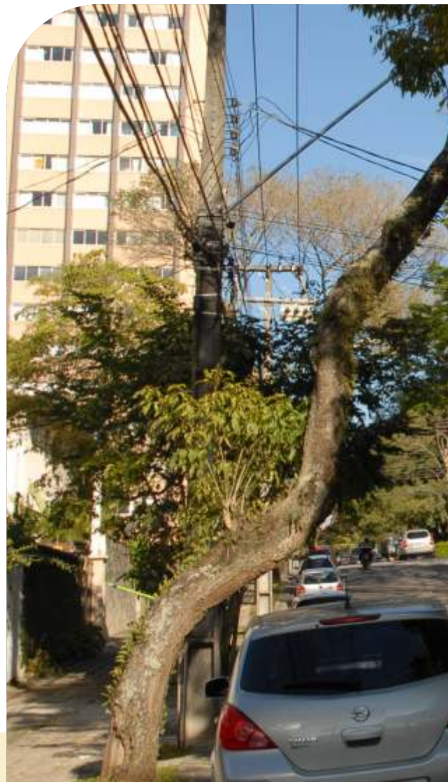
Árvore com risco de queda.
